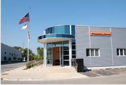
Peddinghaus Corp Bradley, IL
