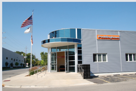
Peddinghaus Corp Bradley, IL
