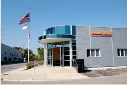
Peddinghaus Corp Bradley, IL
