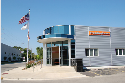
Peddinghaus Corp Bradley, IL
