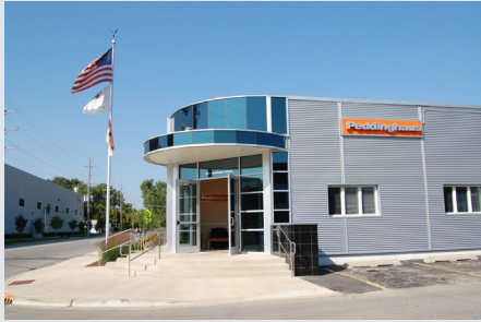
Peddinghaus Corp Bradley, IL
